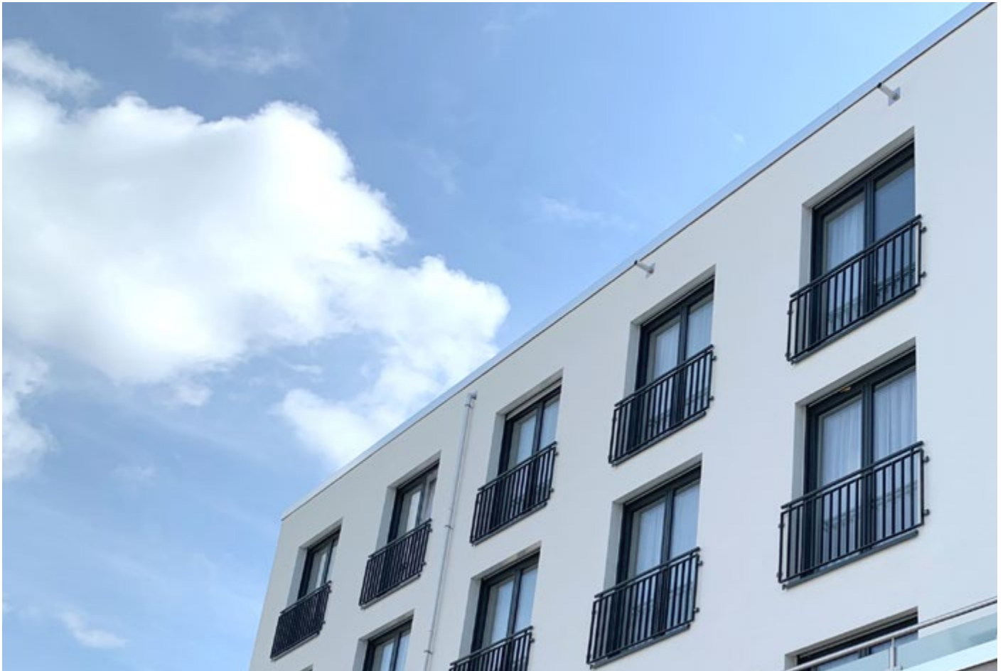
Neubau des Hotels „Deutscher Hof“ in Kassel ausgestattet mit modernen Luft/Luft-Wärmepumpen von Hitachi.
