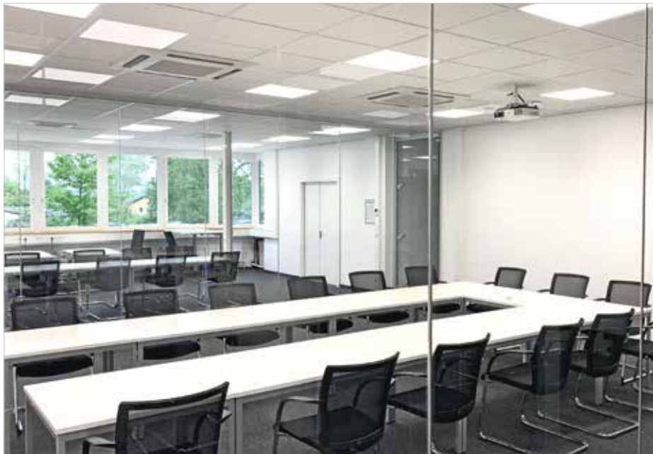
Kassettengeräte mit Frischluftanschluss
