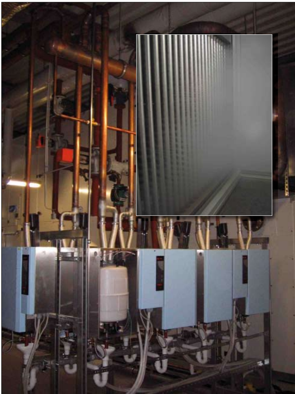
Kaut Befeuchtung: Silesia Aromaherstellung Neuss
