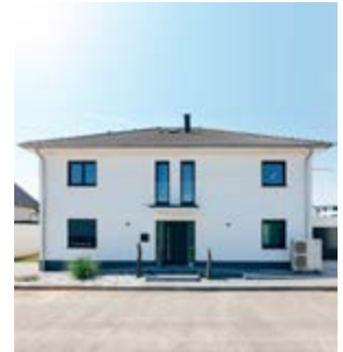
Villa in einer neuen Wohnsiedlung in Bruchköbel (Deutschland)
