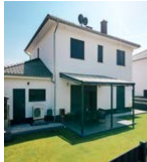
Neues Haus in Erlensee bei Frankfurt am Main (Deutschland)
