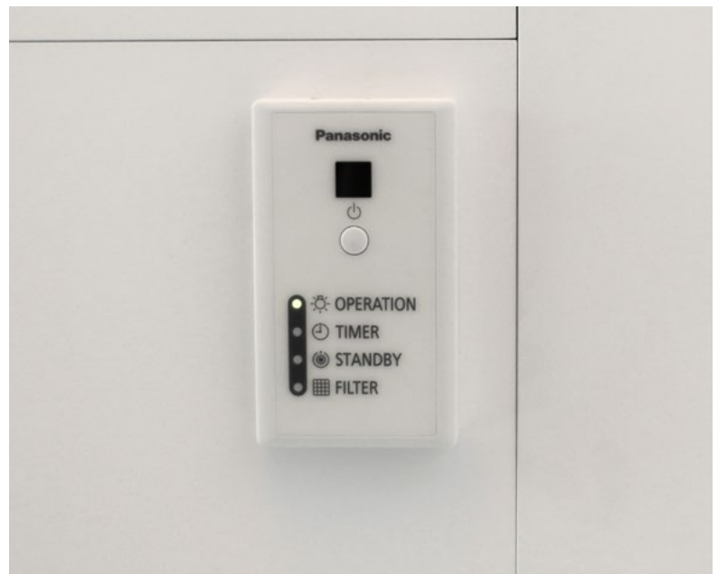
Fernbedienung zur Steuerung der Inneneinheiten
