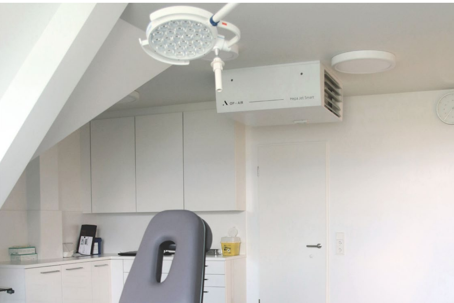
Hepa Jet Smart Unterdeckengerät erfüllt die Hygieneanforderungen an Reinraumbereiche
