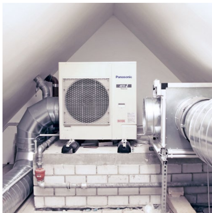
Innenaufstellung der Mini ECOi-Außeneinheit
