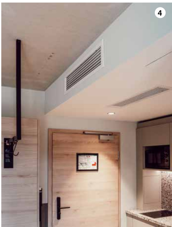
Nahezu unsichtbare Installation von Kanalanschlussgeräten
