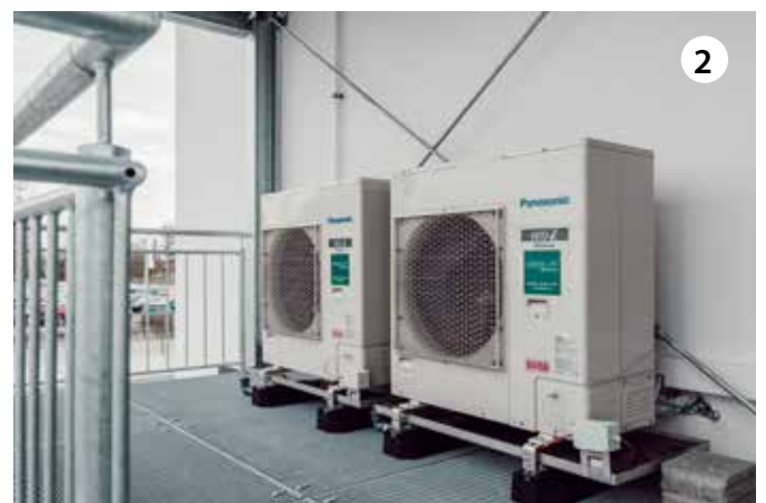
Mini VRF Außeneinheiten von Panasonic
