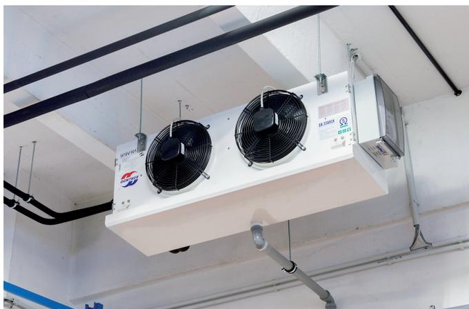
*Eine gelungene Kombination: Von Kaut eigenentwickeltes Fremdverdampferkit mit Kühlraumverdampfer von Güntner*
